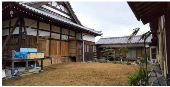
解体工事完了
